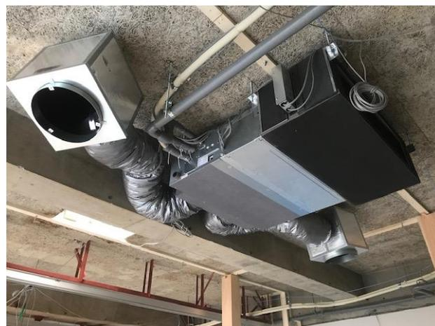
新型コロナウイルス感染症の流行を踏まえ、ウイルス・浮遊菌・花粉・PM2.5 を抑制する空気循環ファンの導入や、除菌ユニットを組み込んだ空調機を設置するなど、感染症予防を意図した改修を行いました。機械換気による二酸化炭素濃度の低減と、浮遊するウイルス等の不活化を目的としています。
