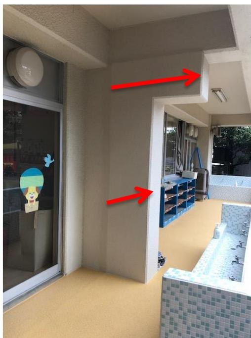
配筋とコンクリート打設により、構造柱の強度アップし、耐震性能が向上しました。
